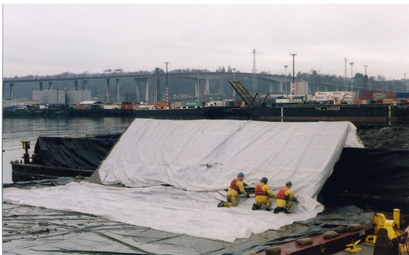
Use of spill apron
